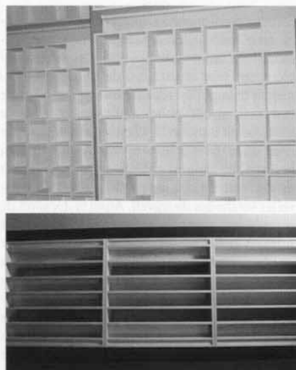
Traitement acoustique : exemples de diffuseurs monté sur les murs.
